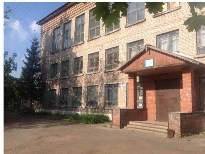
Корпус №1 – г.Вязьма ул. 25 Октября д.3а
